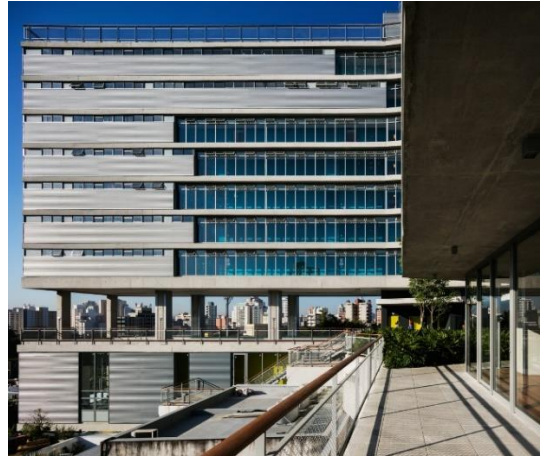
Figura 14 – Circulação do edifício Pop Madalena.
