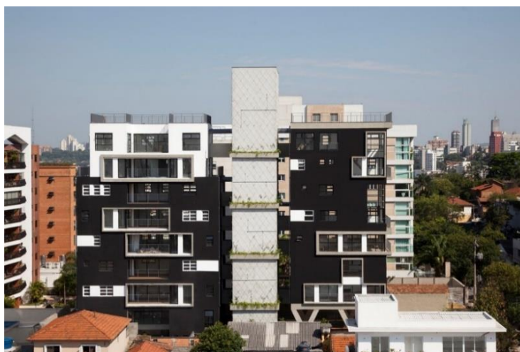
Figura 5 – Foto aérea do edifício Fidalga 727 / São Paulo.
