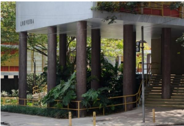
Figura 15 - Passeio que dá acesso ao hall de acesso do edifício Louveira.
