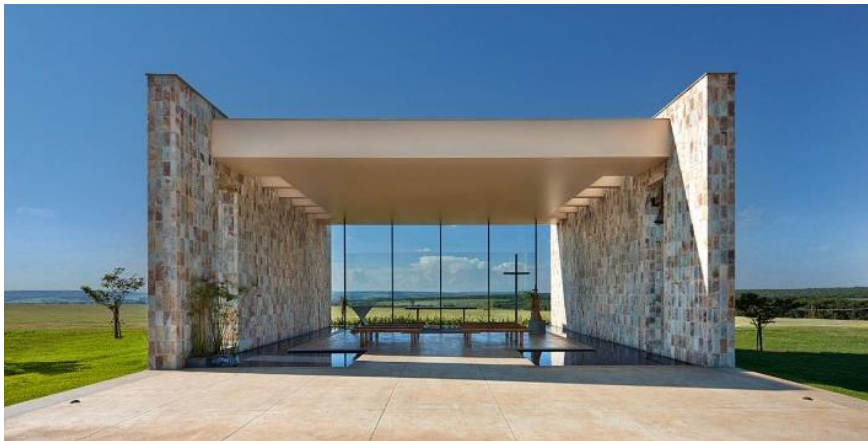
Figura 5: Vista frontal da Capela da Fazenda Santa Helena.
