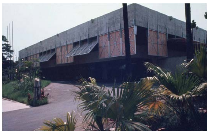
Figura 1 - Vista da fachada frontal do clube Harmonia, com os painéis móveis de fechamento lateral.
