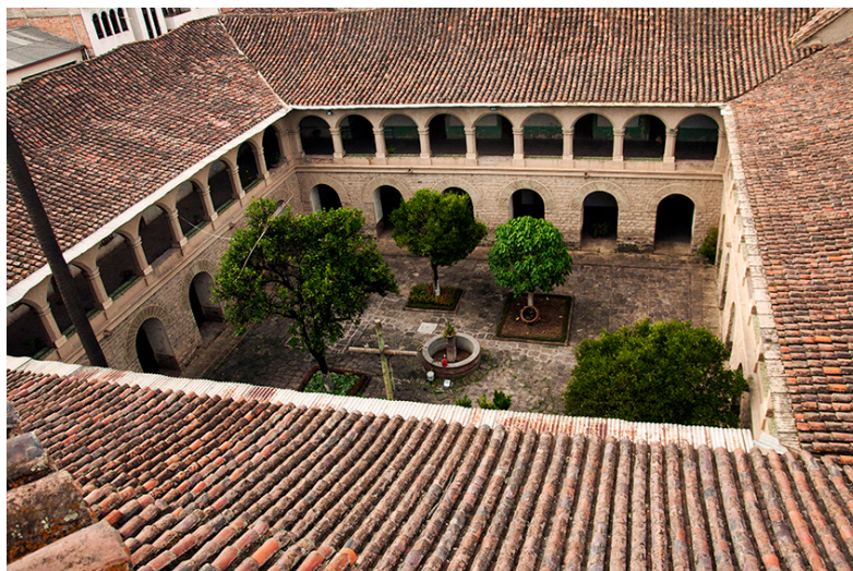
Figura 2 - Vista Parcial do Claustro do Monastério de Santa Teresa.
