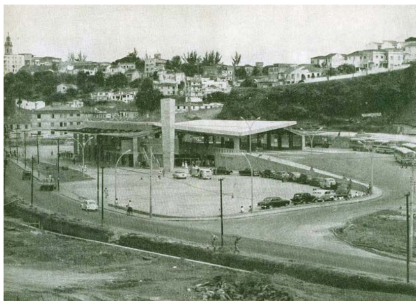
Figura 1 - O protagonismo do edifício na paisagem em construção.
