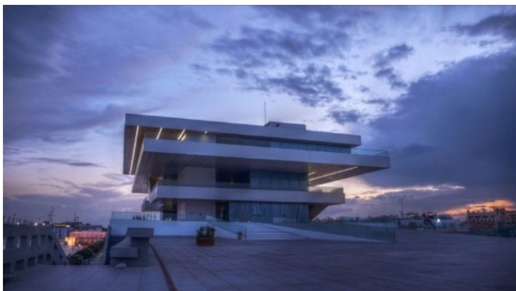
Figura 8 - David Chipperfield, Edifício Veles e Vents, Valencia, 2005. Sem ser um bloco compacto ou composição elementar ortodoxa possui estrutura formal muito clara
