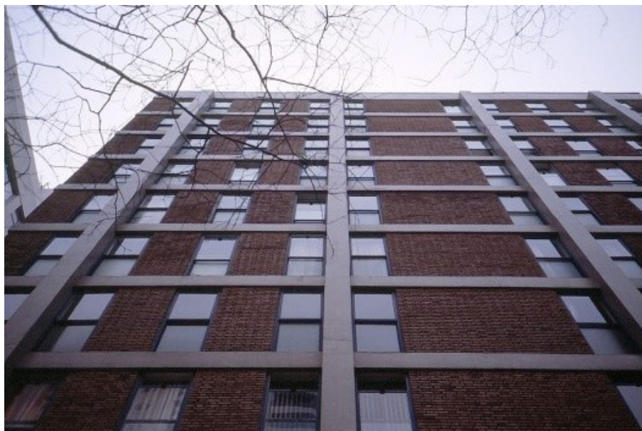
Figura 15 - Eduardo de Almeida, Edifício Residencial Gemini, São Paulo, 1970-71. Uma solução em que nada falta e nada sobra, e máximo proveito estético é tirado de elementos indispensáveis como pilares e vigas
