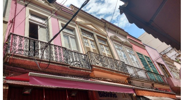
Figura 3 - Sobrados na Rua da Alfândega
