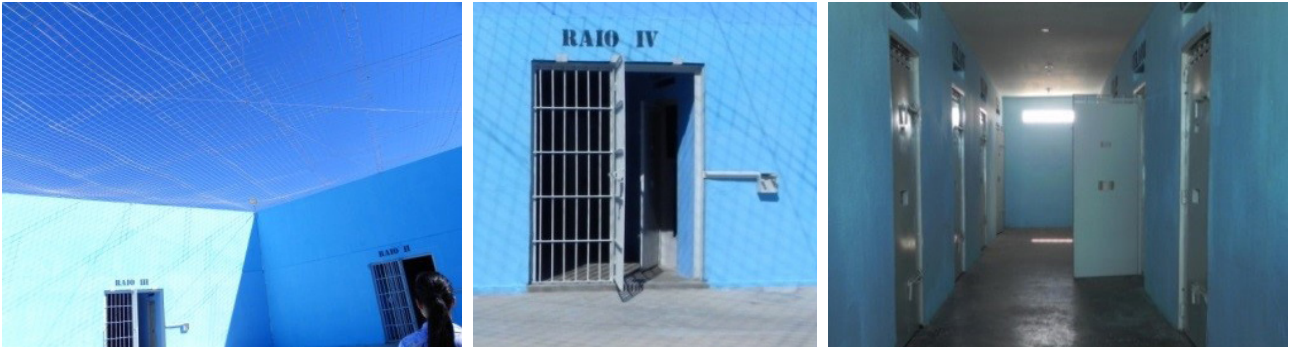
Figura 5 - Vista do pátio central do módulo de vivência e vista externa e interna de um dos raios de celas
