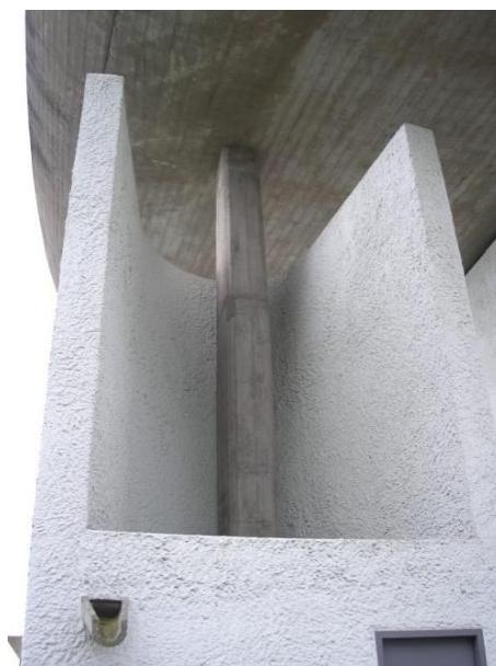
Figura 8: Contraste entre a cobertura e o pilar de concreto aparente bruto, e a superfície pintada de branco da fachada leste da Capela de Notre-Dame-du-Haut, Ronchamp, 1950-1955.
