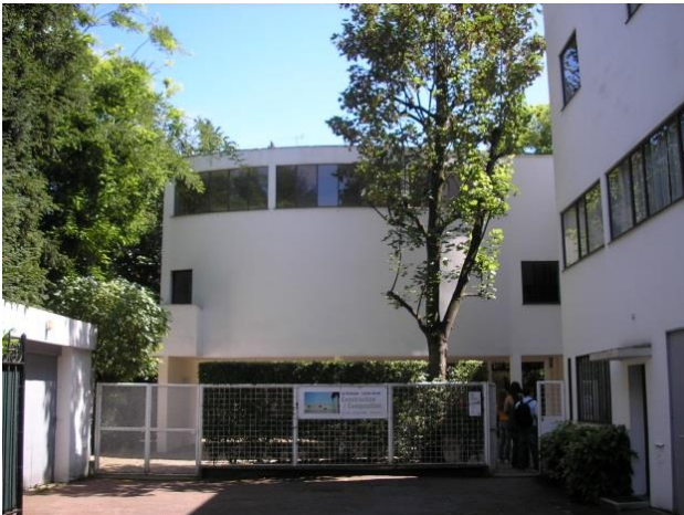
Figura 1: Vista externa das residências da Vila La Roche-Jeanneret, Paris, França, 1923.
