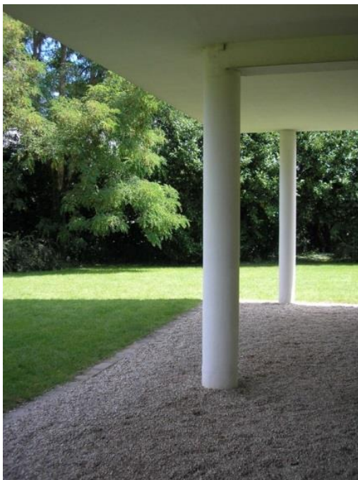
Figura 3: Detalhe dos pilotis, viga e laje do pavimento térreo, pintados de branco na Vila Savoye, Poissy, França, 1928-1931.
