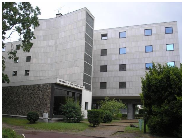
Figura 6: Vista da fachada norte, com poucas aberturas para iluminação das circulações horizontais de acesso aos apartamentos, e à frente, o bloco da circulação vertical, com uma empena cega, composta por painéis pré-fabricados, no Pavilhão Suíço da Cidade Universitária de Paris, Boulevard Jourdan, 1929-1933.
