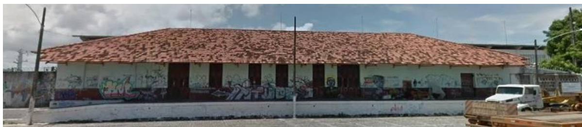
Figura 10: Fachada principal do Antigo Frigorífico, antes da intervenção arquitetônica.
