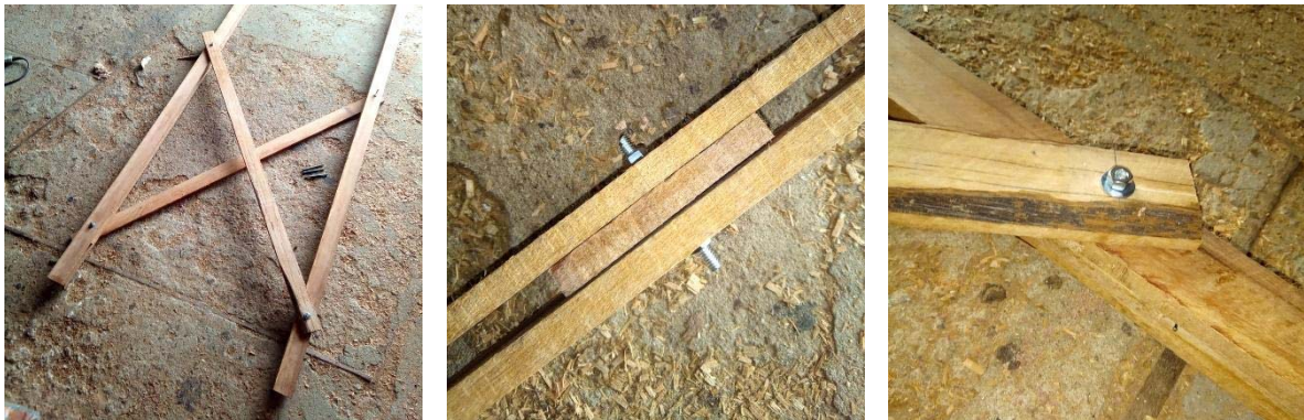
Figura 11: Montagem do mockup
