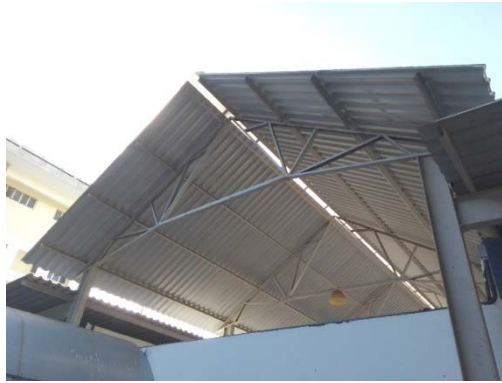
Figura 2: Treliça da cobertura dos Laboratórios de Arquitetura (projeto do arquiteto Fernando Costa)
