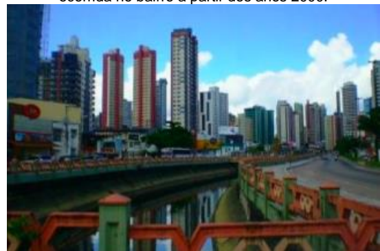
Imagem 2: Foto de 2012 tirada do mesmo ponto da foto que consta na Imagem 1, destacando a intensa verticalização ocorrida no bairro a partir dos anos 2000.
