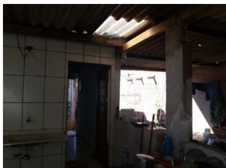
Figura 20: Telha translúcida em ampliação no fundo.
