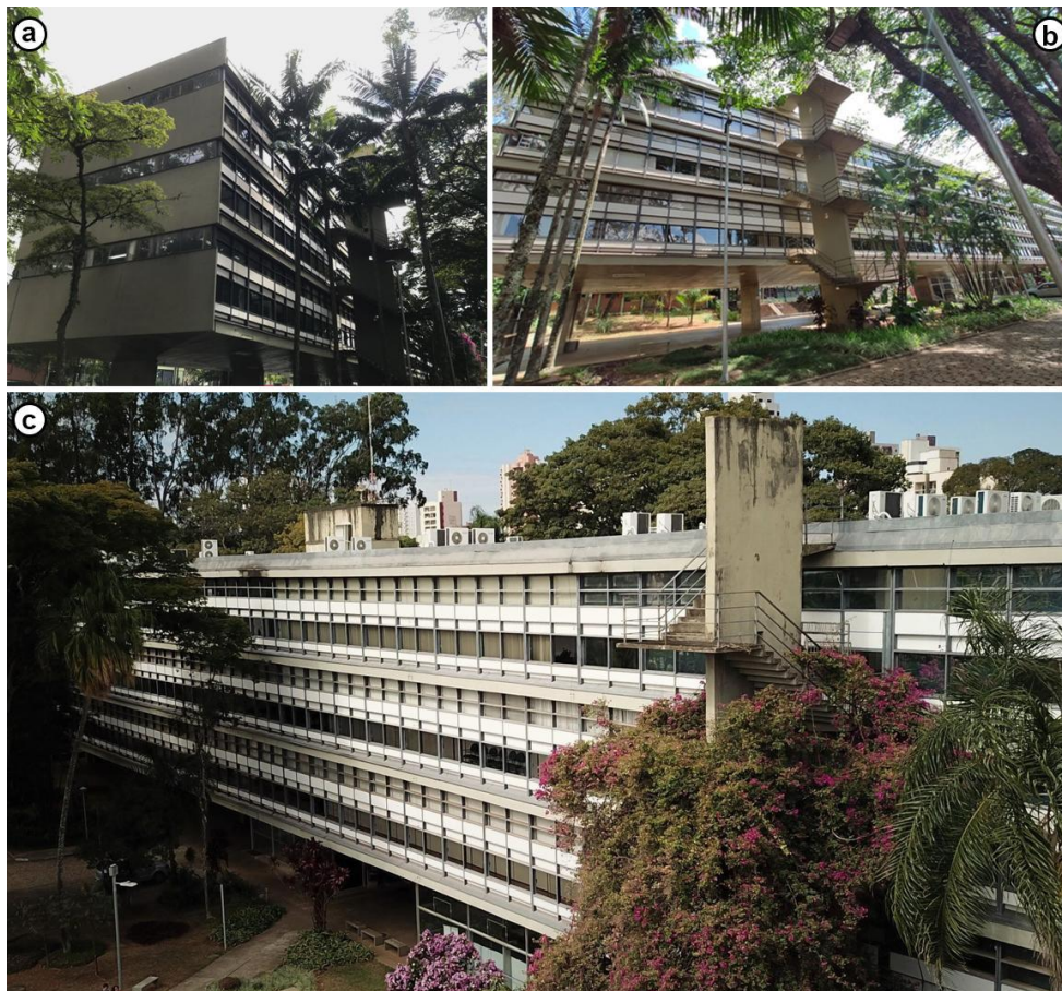
Figura 1: Vistas externas do edifício E1.
