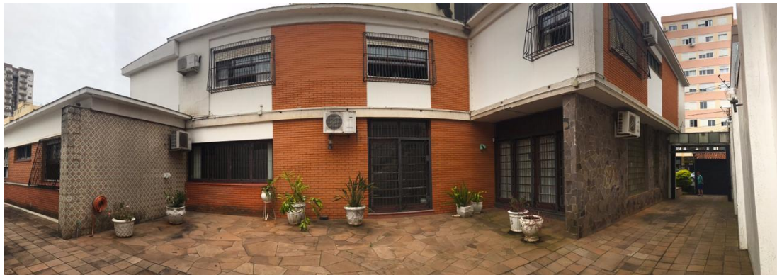
Figura 12: Imagem panorâmica da lateral da edificação (contém distorções devido a formato).
