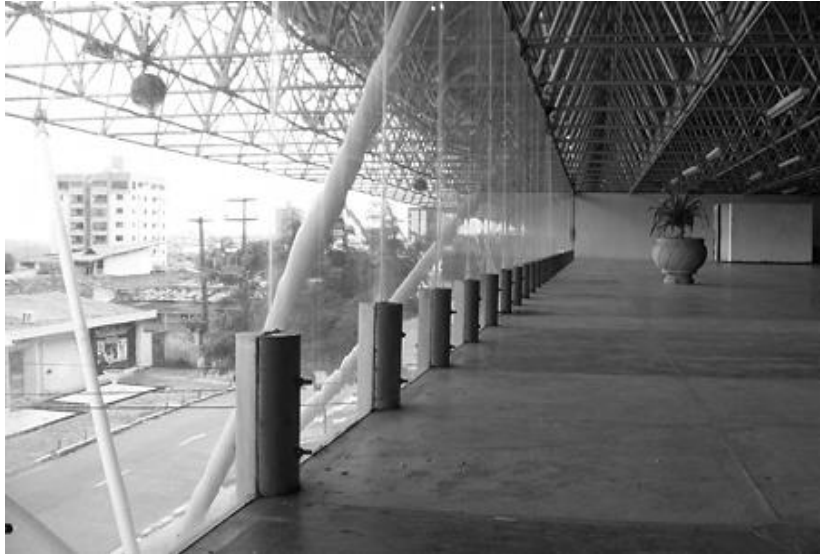
Figura 12: Painéis de vidro como elemento de vedação de alguns ambientes do mezanino promovem o diálogo interior/externo.
