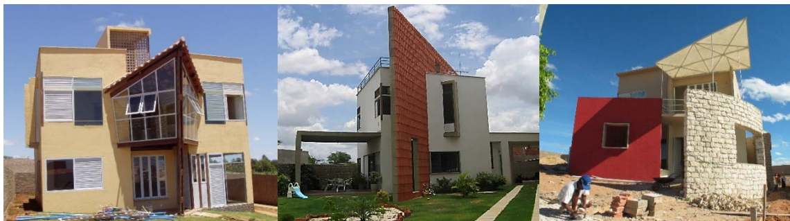
Figura 10: Casas Irmãs II – Família: Casa Compacta, Casa Curva e Casa Barco, em Juazeiro/BA (2004-2005).
