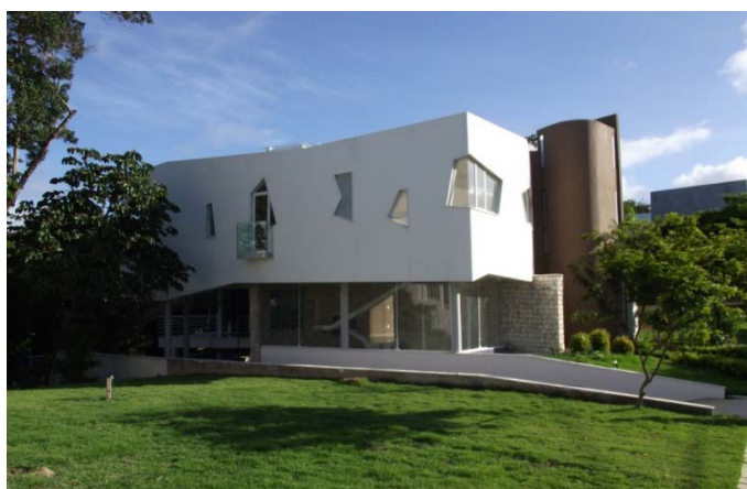
Figura 7: Casa Fusão, Alphaville, Salvador (2012).
