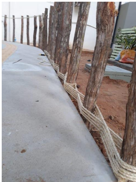
Figura 9: Execução da barreira física para auxiliar na orientação do visitante cego.
