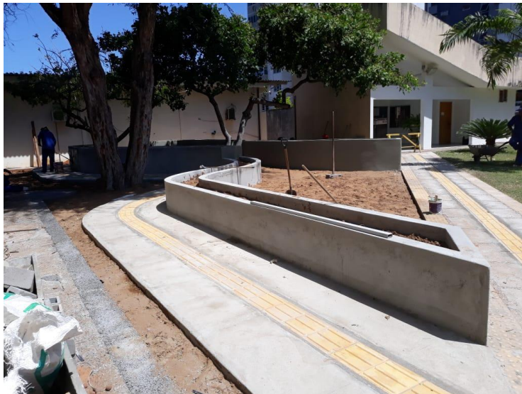
Figura 7: Execução do piso.
