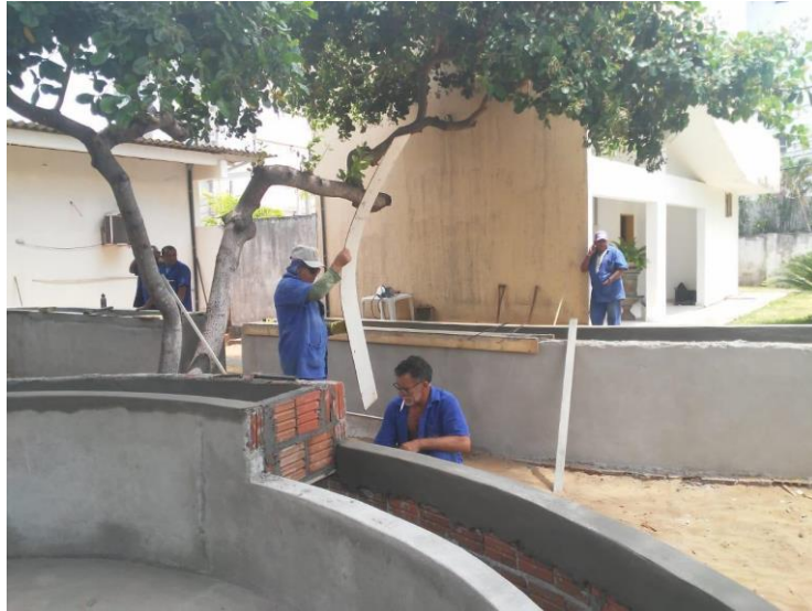
Figura 6: Execução das jardineiras em diferentes alturas.
