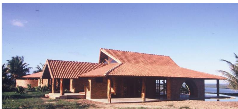
Figura 10: Casa Amaragi, Rio Formoso - PE, 1994. Arquitetura 4 (Carmen Mayrinck, Vera Pires). Articulação volumétrica, que integra espaços cobertos, semicobertos e abertos com a paisagem circundante.
