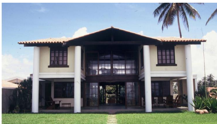
Figura 9: Casa Acioly, Porto de Galinhas-PE, 1987. Arquitetura 4 (Carmen Mayrinck, Vera Pires). Classicismo tropical, que explora a centralidade e as transparências.
