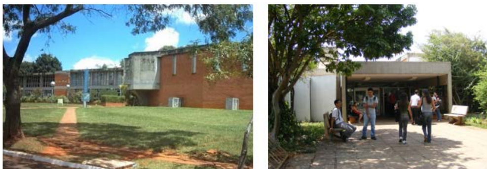
Figura 11: Faculdade de Tecnologia, acesso ao prédio levando a circulação interna que o atravessa.
