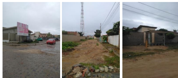
Figura 1: Entrada do empreendimento Cidade Madura (a). Percurso realizado pelo morador até a parada de ônibus mais próxima do empreendimento (b) e Parada de ônibus mais próxima do empreendimento (c).
