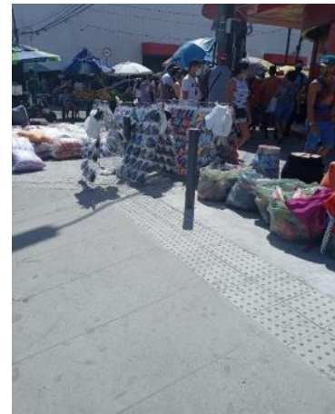
Figura 3 - Piso tátil de alerta no entorno da Estação José de Alencar em desconformidade com a NBR 16537/2016, sem o contraste de cores.
