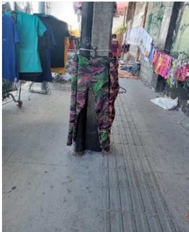
Figura 1: Piso tátil direcional no entorno da Estação José de Alencar em desconformidade com a NBR 16537/2016, sem o distanciamento de 0,60cm de barreiras e contraste de cores.
