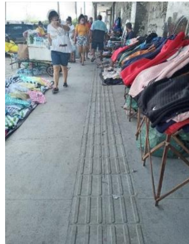
Figura 5 - Piso tátil direcional com obstrução de barreiras atitudinais nas calçadas do entorno da Estação José de Alencar.
