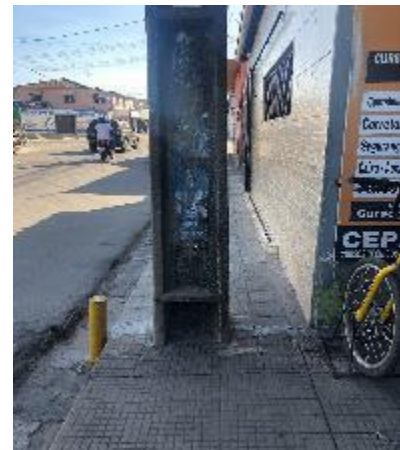
Figura 8 – Calçada estreita na Avenida G com poste posicionado sem condição de faixa livre no passeio (Conjunto Esperança).
