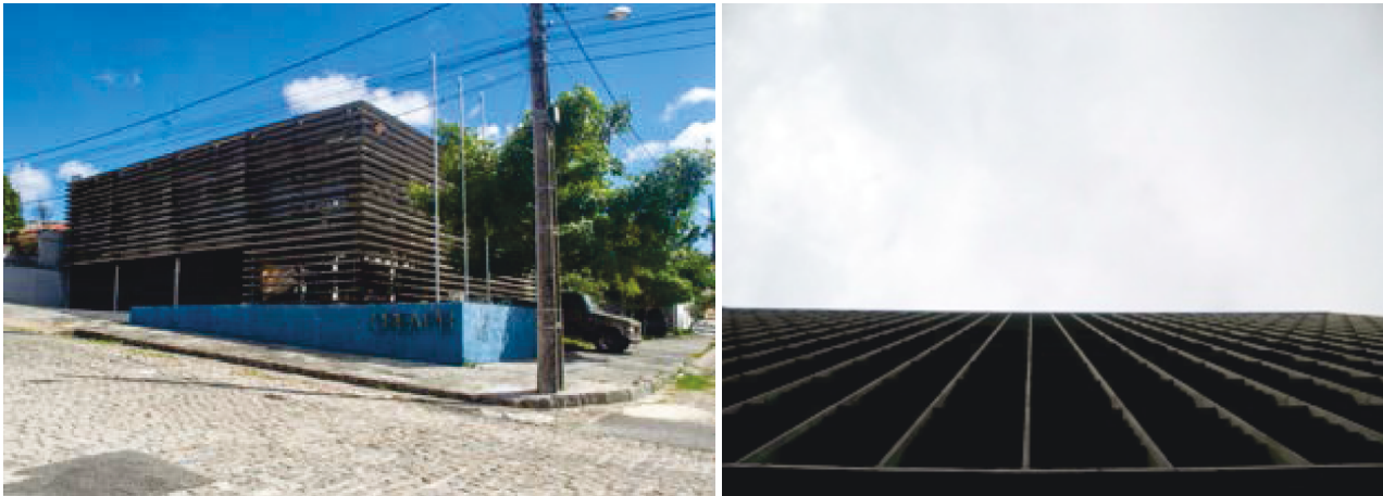
Figura 1: Prédios Institucionais no Brasil - CREA-PB e MEC-RJ.
