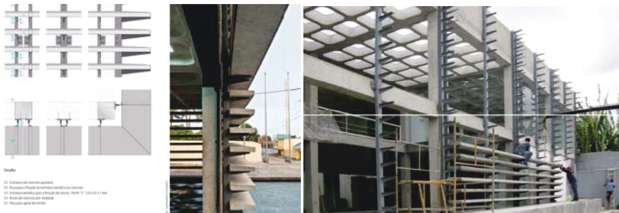
Figura 11: Projeto e execução dos brises horizontais no CREA-PB.
