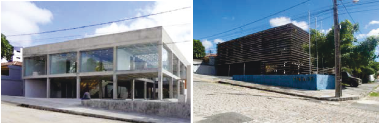
Figura 13: Fachadas do CREA-PB com e sem os brises horizontais.
