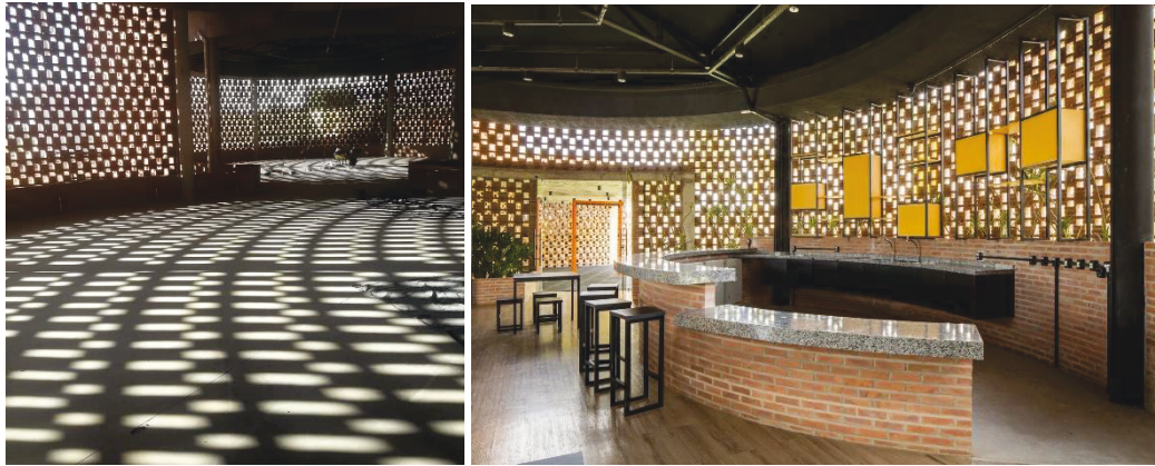
Figura 11: (A esquerda) obra ainda em execução mostrando instalação hidráulica aparente junto ao pilar, (a direita) instalações elétricas sobrepostas no ambiente da cantina.
