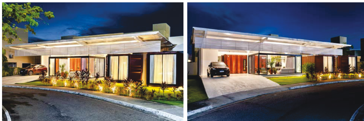
Figura 13: Registros da obra concluída.
