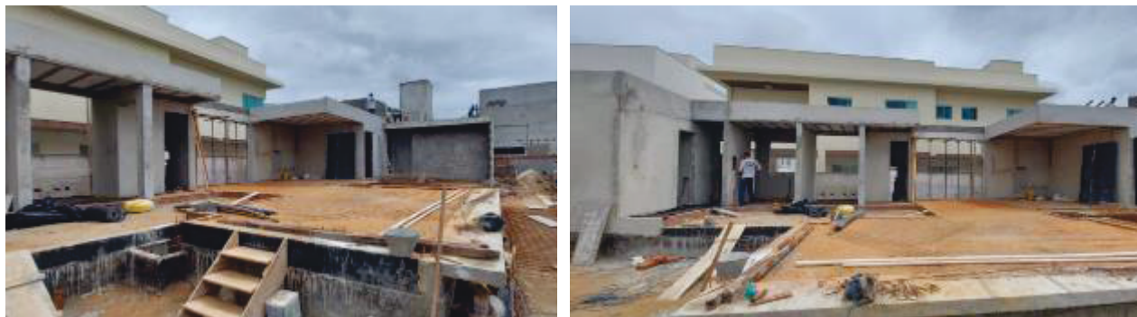
Figura 7: Registro da supraestrutura em concreto armado.
