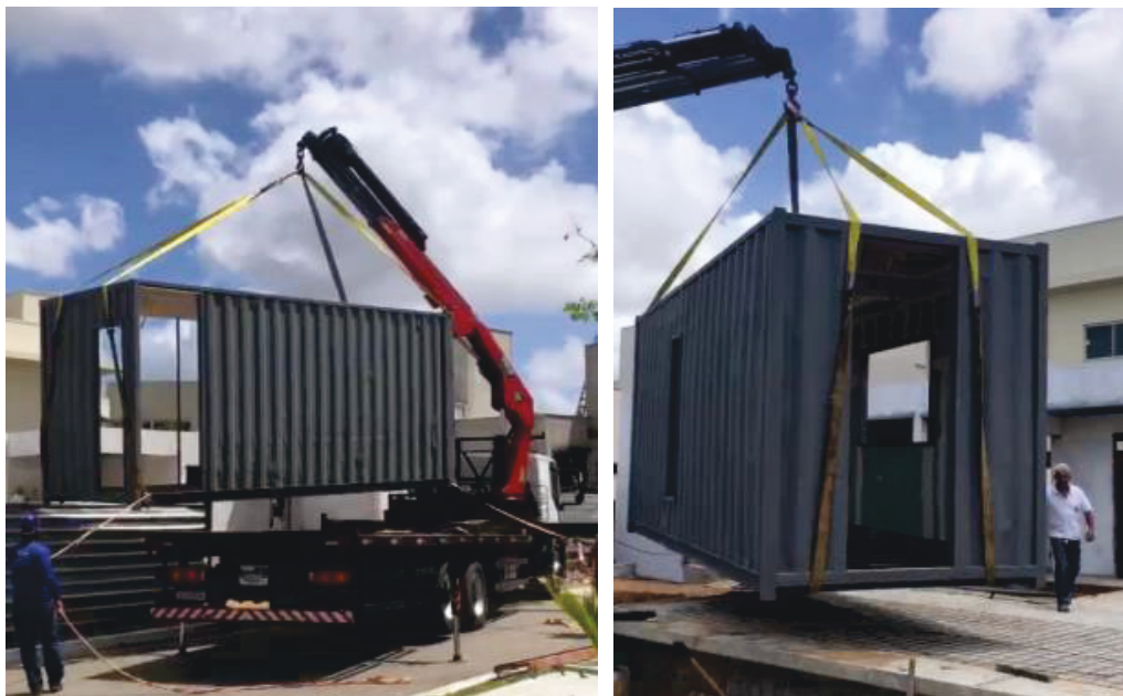
Figura 6: Recepção dos containers durante a obra. Estrutura pronta para acabamentos.
