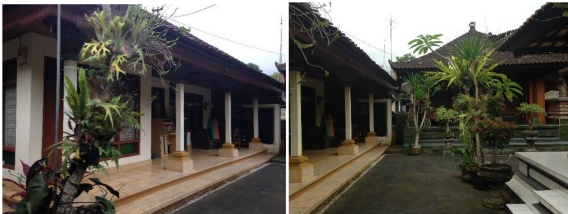
Figura 14: Respectivamente, fachada frontal do Bale do chefe da família (Bale Daja ou Bale Meten); e espaços livres entre o Bale do Chefe da Família, Bale da Família (Bale Delod) à direita, e na parte posterior, Bale de Cerimônia (Bale Dangin).
