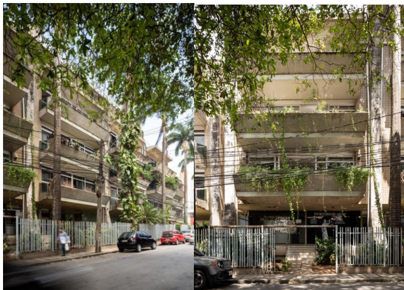
Figura 14: Foto atual do Edifício Magna Santos Dumont
