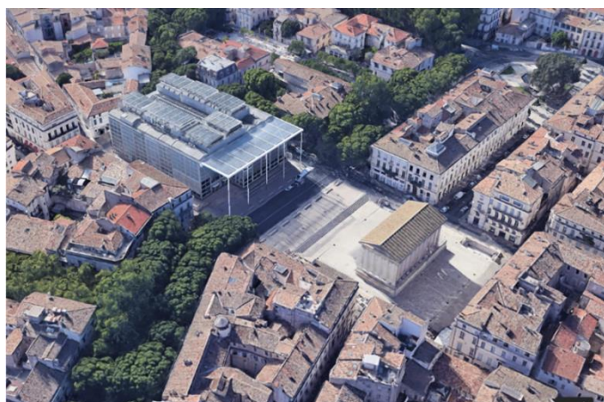
Figura 5: O local, com o novo edifício.
