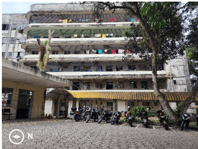
Figura 04: Vista das varandas da ala oeste do HUIBB, voltadas para o antigo acesso principal.
