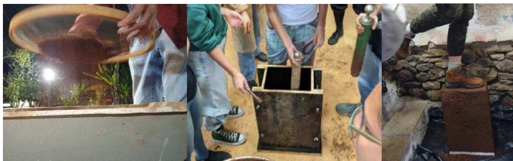
Figura 1: Prática da taipa de pilão, respectivamente: peneiramento (esq.), compactação (centro), e do teste pós-desmoldagem com a taipa (dir.), 2023.
