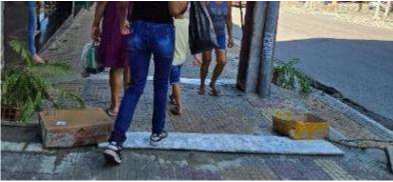
Figura 18: Atenção no piso
