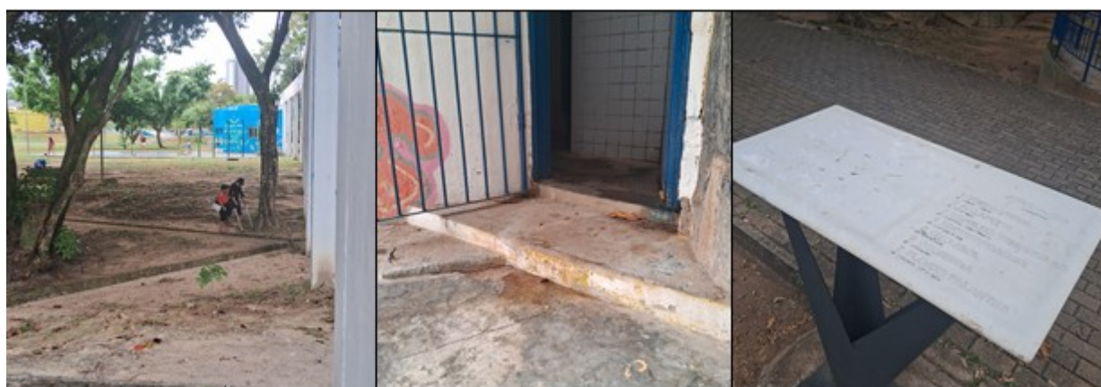
Figura 9 – Áreas de risco e equipamentos danificados no parque. Da esquerda para à direita, temos: (i) rede de escoamento pluvial sem proteção no meio do percurso, obrigando o desvio; (ii) entrada inacessível do sanitário masculino e (iii) sinalização tátil danificada.
