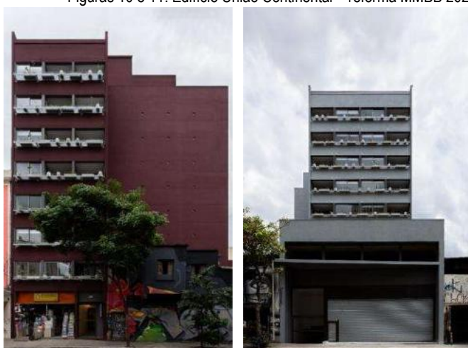
Figuras 10 e 11: Edifício União Continental – reforma MMBB 2022.
