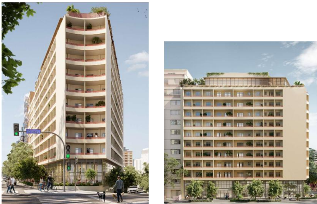
Figura 14 e 15: Edifício Virginia (1951) José Augusto Bellucci – reforma (2024) Metrôpole Arq.
