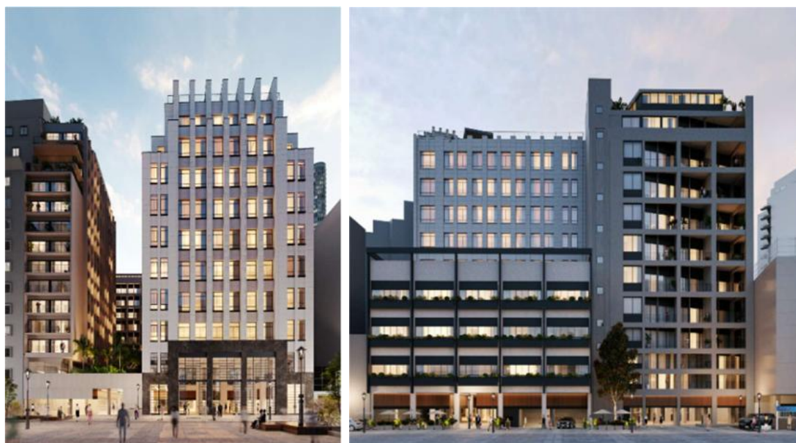
Figura 12 e 13: Edifício Basílio 177 Severo e Villares (década 1940) – reforma Metro Arquitetos, 2024.
