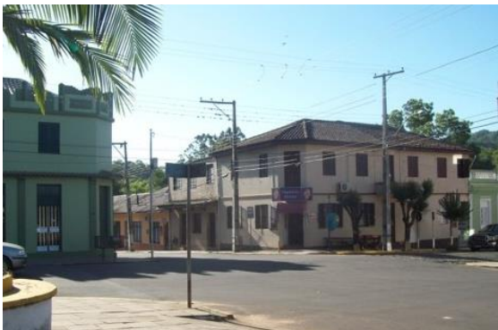
Edificações da área central.
