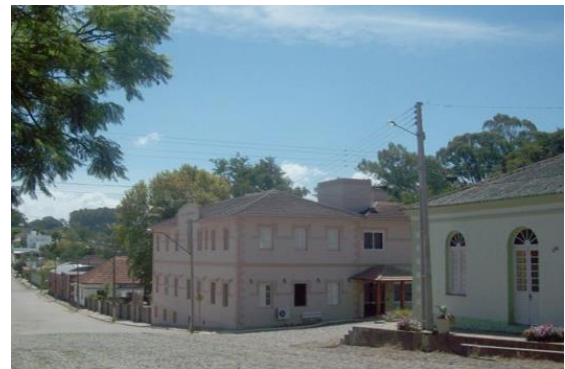
Edificações da área central.
