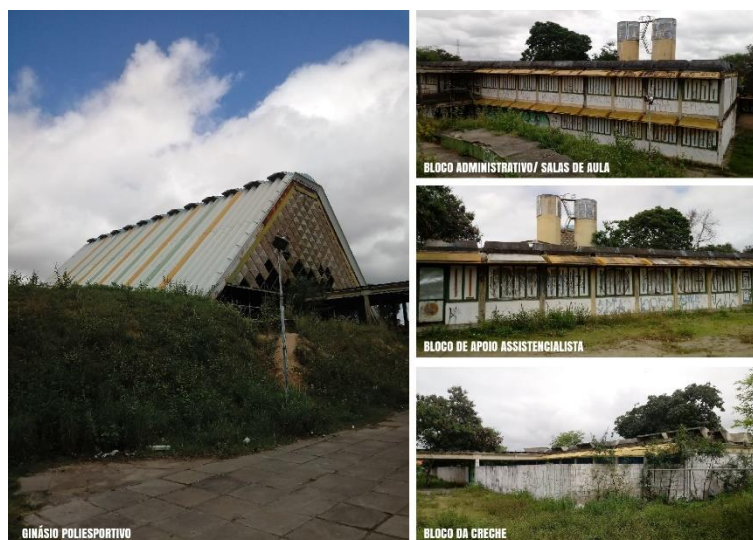
Figura 1: A obra do arquiteto João Filgueiras Lima, conhecido por Lelé (1932-2014).
