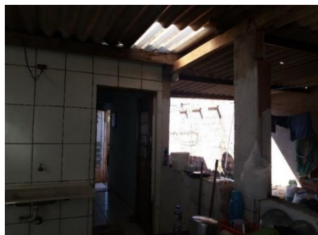
Figura 20: Telha translúcida em ampliação no fundo.
