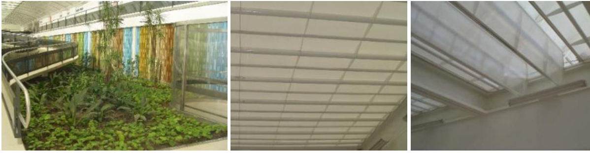
Figura 3: Cobertura e forrers móveis do Hospital Sarah Kubitschek – Rio de Janeiro.
