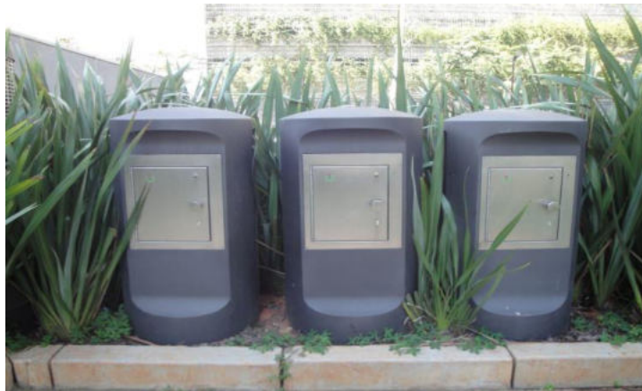
Figura 6 – Sistema de processamento seletivo de resíduos à vácuo, Torre Jequitibá - Parque da Cidade.
