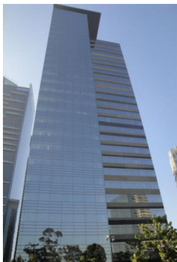
Figura 3 – Torre Tarumã, complexo Parque da Cidade.
