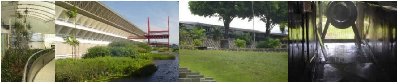
Figura 2: Estratégias de conforto nos hospitais Sarah: luz pelos sheds ; espelho d'água e brises; galerias com resfriamento evaporativo.
