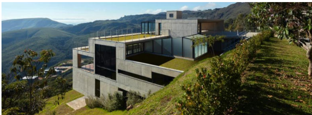
Figura 8: Sonastério, vista desde passeio frontal
