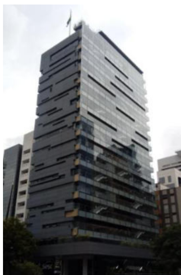
Figura 4 – Edifício SESC Paulista.
