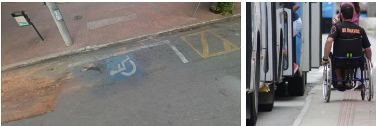
Figura 3. a) destaque da vaga prioritária sem acesso direto à calçada via rebaixamento de calçada; b) representação de um cadeirante na dificuldade de procurar como entrar no ônibus.
