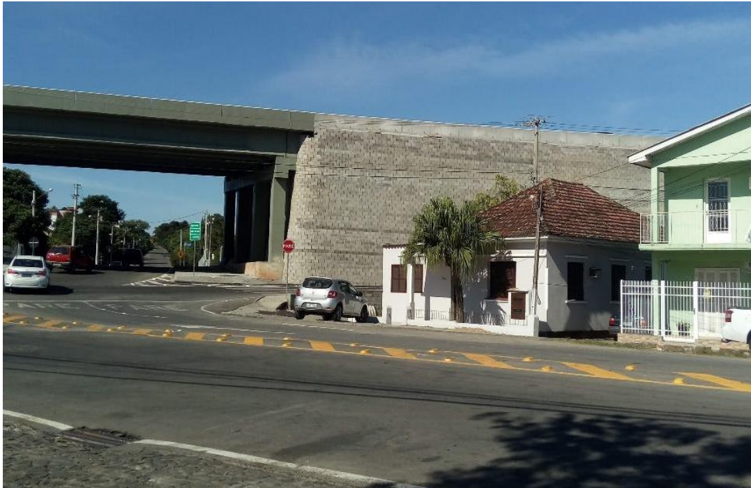
Figura 3: Foto do viaduto.
