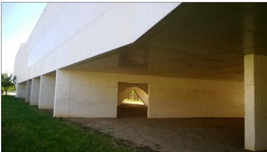
Figura 3: Ao incluir recortes de motivos geométricos como passagens entre alguns dos pilares laminares moldados em concreto branco, Siza prestou uma homenagem sutil e inusitada à arte pictórica de inspiração matemática de Nadir Afonso.
