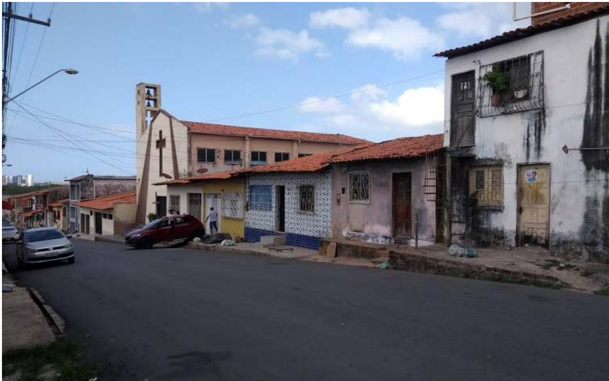
Figura 03: Vista do lado oposto à fachada da UEB Dayse Linhares, mostrando a situação da calçada e a falta de faixa de pedestre.
