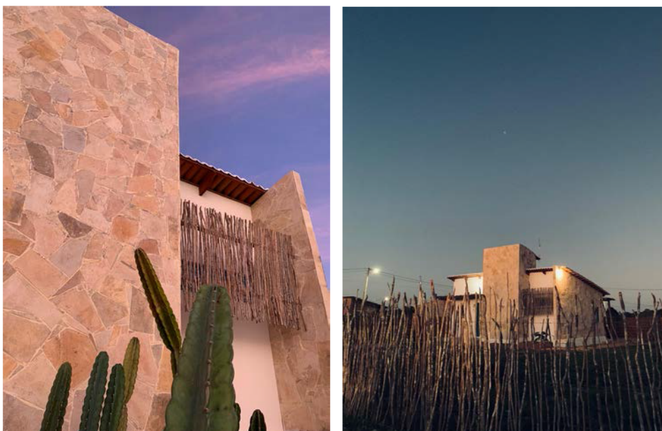
Figuras 13 e 14: Aplicação de pedra Antiqua na fachada, protetor solar vertical instalado sobre esquadria e cerca de faxina.
