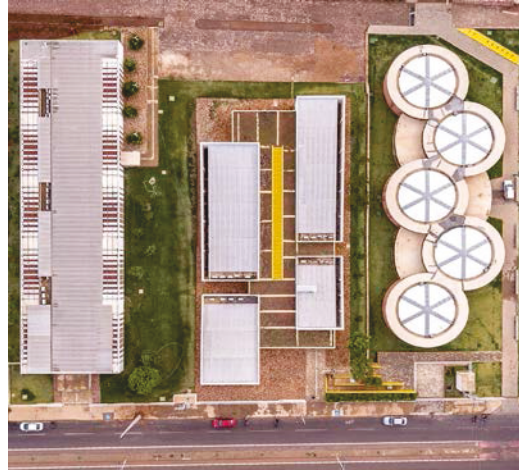
Figura 6: Vista aérea de três edifícios no Campus Unileão projetados pelo Lins Arquitetos e Associados, (a direita) a Academia-escola Unileão.
