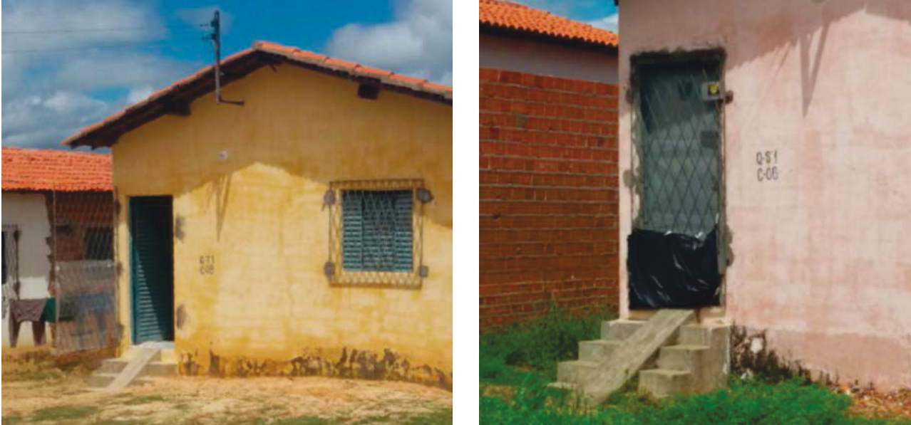
Figura 10: Rampas improvisadas para facilitar a guarda de motocicleta
