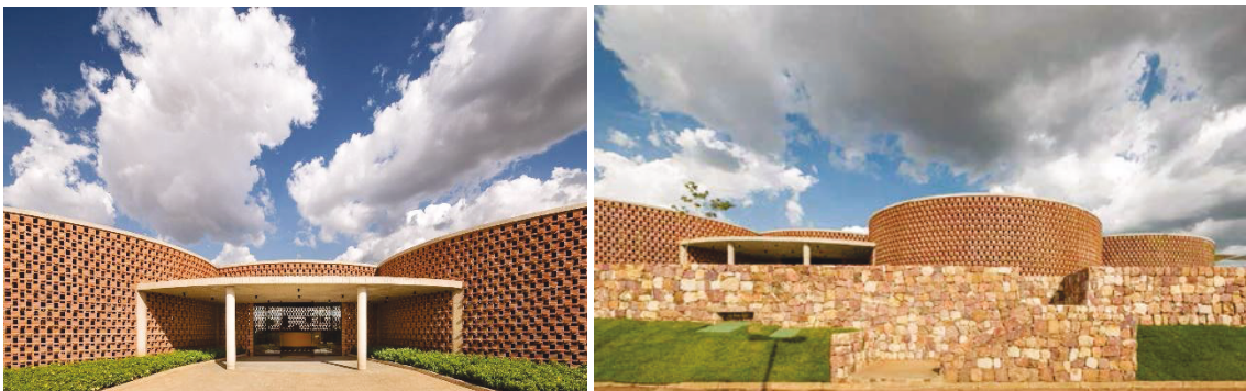
Figura 1: Fachada frontal da Academia-escola Unileão. (À esquerda) entrada principal, (à direita) entrada a partir dos platôres.
