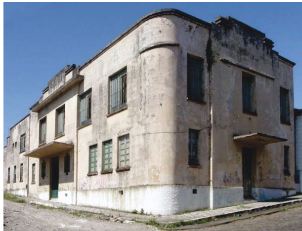
Figura 5: Clube dos Ferroviários, 2021.
