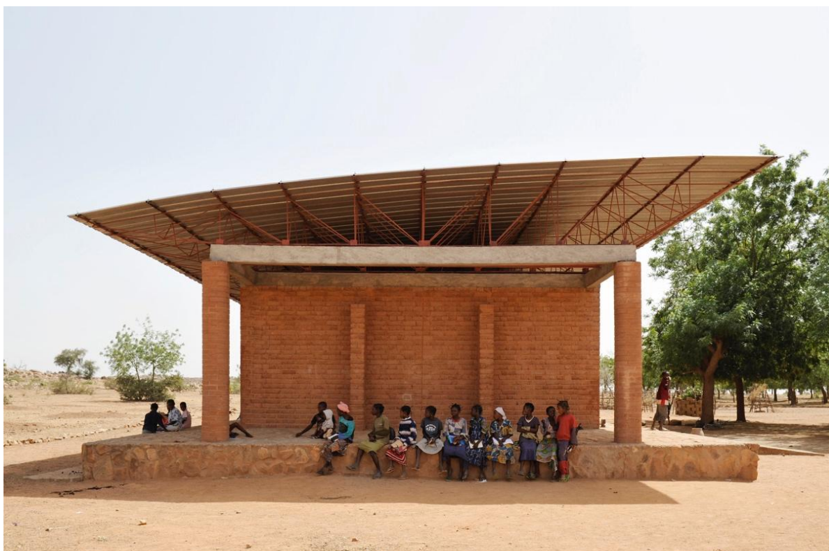
Figura 3: Escola Primária de Gando
