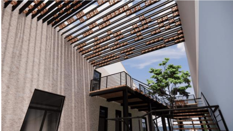
Figura 7: Vista interna do espaço de passagem e deck elevado do restaurante, com detalhe para a solução de elemento vazado que faz referência à cobertura original perdida.
