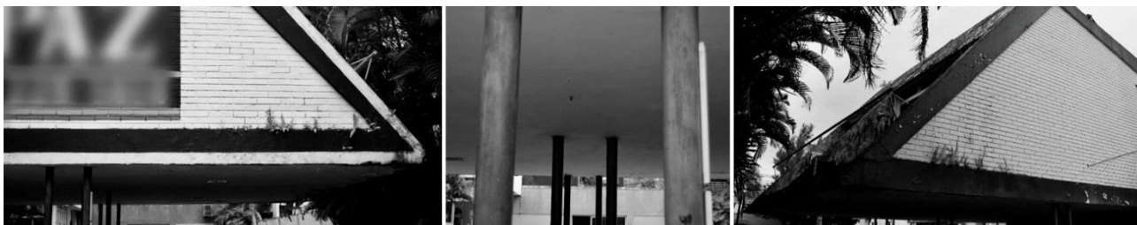
Figura 14: Detalhe dos pilares em aço que sustentam parte das cargas do pavimento superior.
