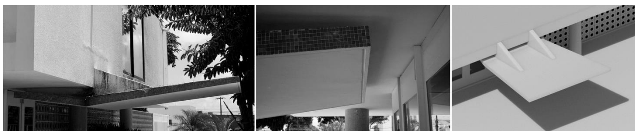
Figura 11: Detalhe da marquise em “v”.
