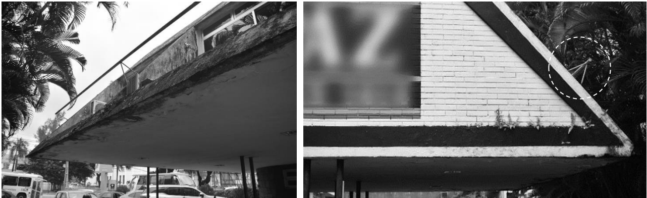
Figura 19: Detalhe guarda corpo metálico do pavimento superior.
