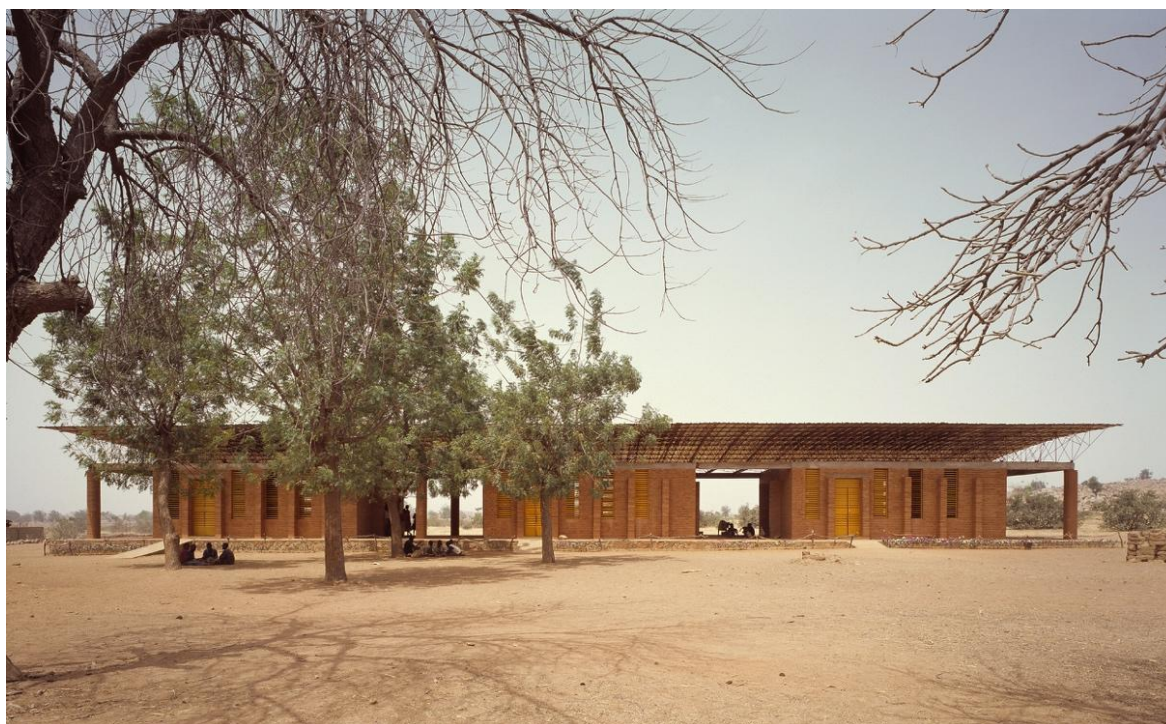
Figura 6: Escola Primária de Gando
