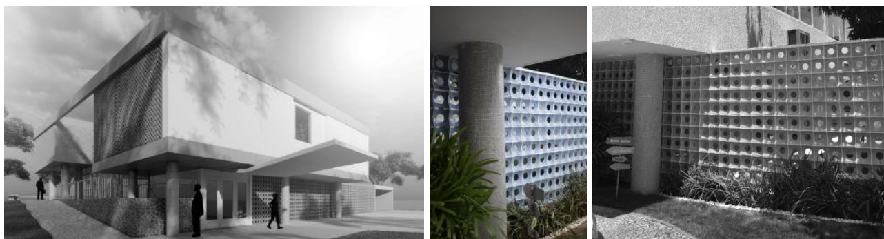
Figura 17: Parede de cobogós azuis isolando o setor de serviço.
