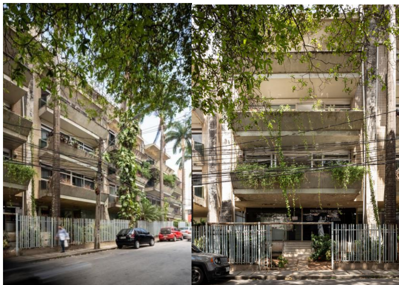
Figura 14: Foto atual do Edifício Magna Santos Dumont
