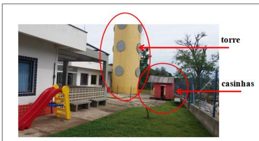
Figura 13: Pátio externo – torre do reservatório
