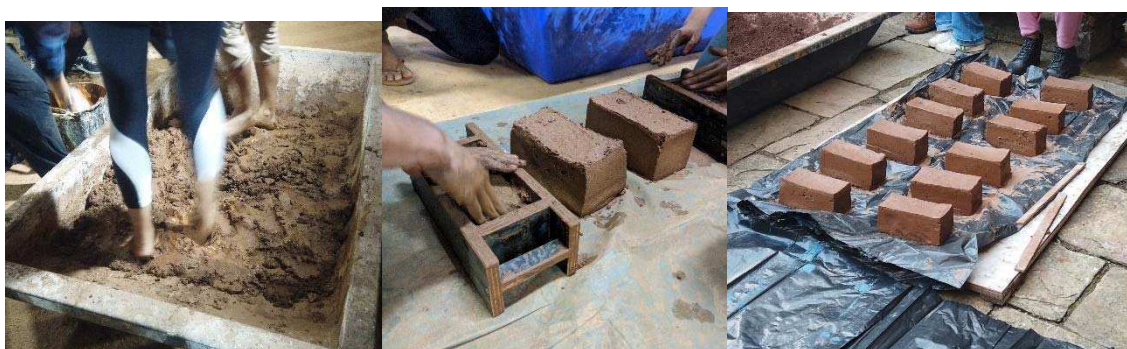
Figura 2: Prática do adobe, respectivamente: amassamento do solo na Oficina 2 (esq.), moldagem na Oficina 1 (centro), e dos adobes prontos na Oficina 3 (dir.), 2023.
