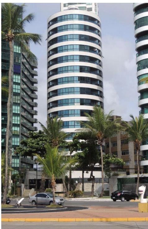
Figura 6: Edifício Zara, Av. Boa Viagem, 1478, Boa Viagem, Recife-PE
