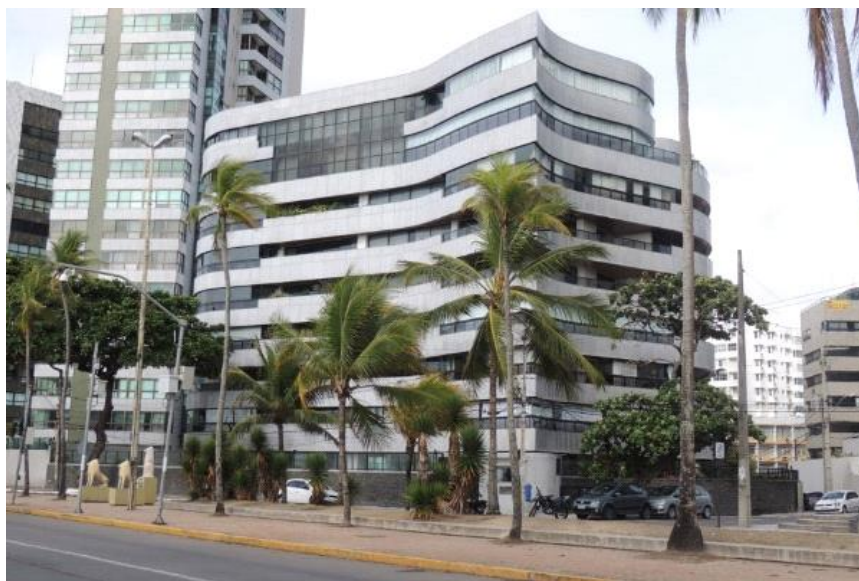
Figura 5: Edifício Casa Alta, Av Boa Viagem, 2054, Boa Viagem, Recife–PE
