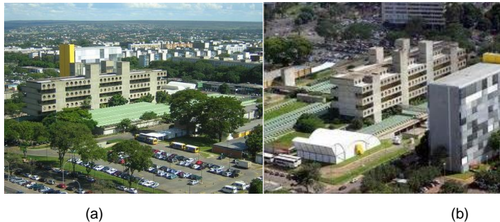
Figura 1: O conjunto arquitetônico do Hospital Sarah Asa Sul implantado em área adensada: a) Vista do bloco principal; b) Complexo hospitalar.
