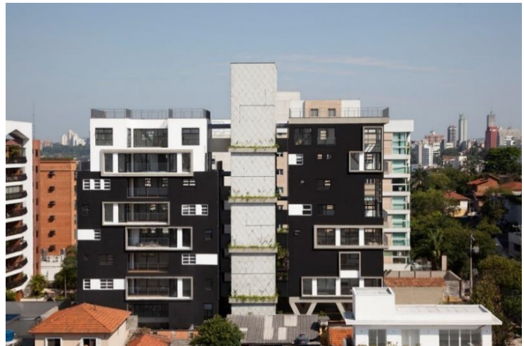
Figura 5 – Foto aérea do edifício Fidalga 727 / São Paulo.
