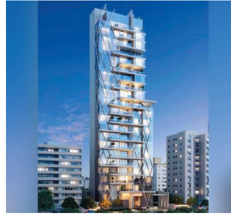
Figura 6 – Perspectiva comercial do edifício Llum Batel, em Curitiba-PR.
