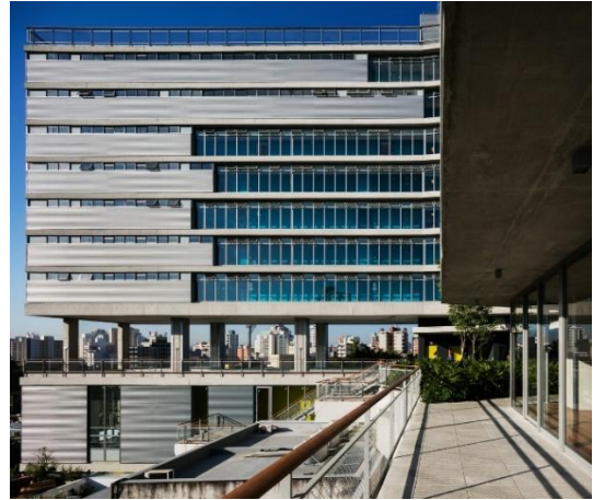
Figura 14 – Circulação do edifício Pop Madalena.
