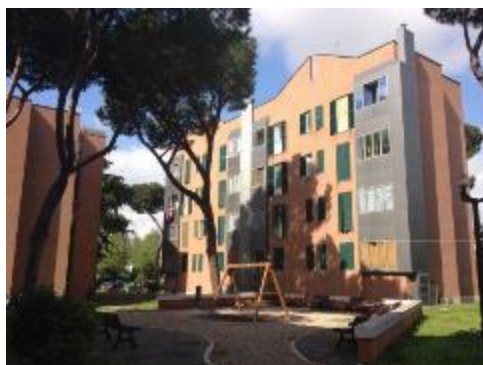
Figura 14: Fechamento das varandas com placas de alumínio após a reabilitação do San Basilio
