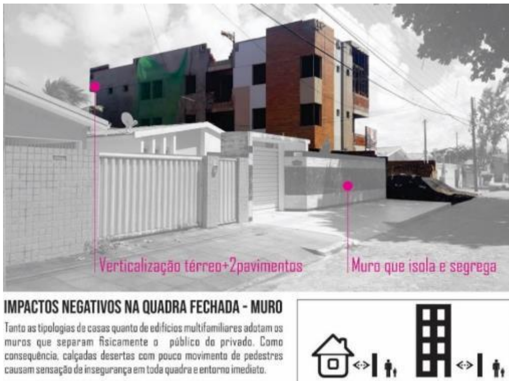
Figura 12: Muro e segregação público x privado.
