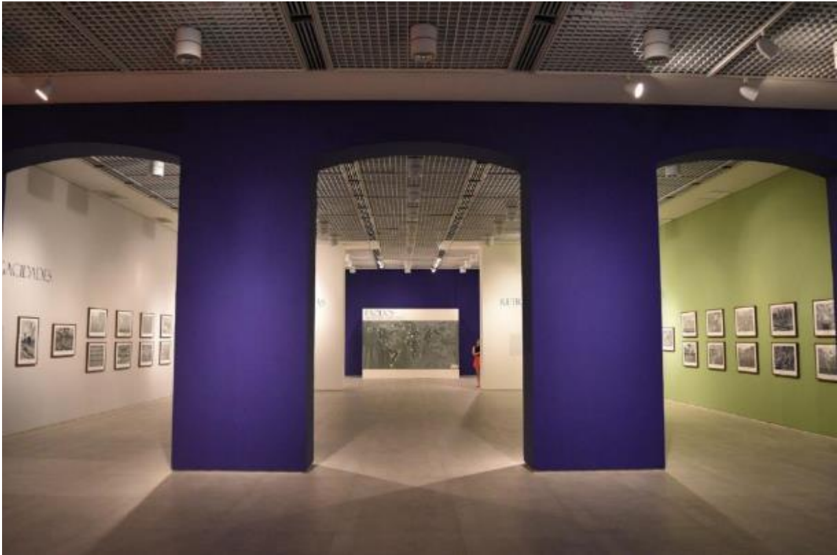
Figura 8: A adição de painéis de madeira no interior da galeria compromete a leitura interna do edifício quanto à sua autenticidade, pois não há distinção entre as colunas históricas e as paredes adicionadas com a intervenção.
