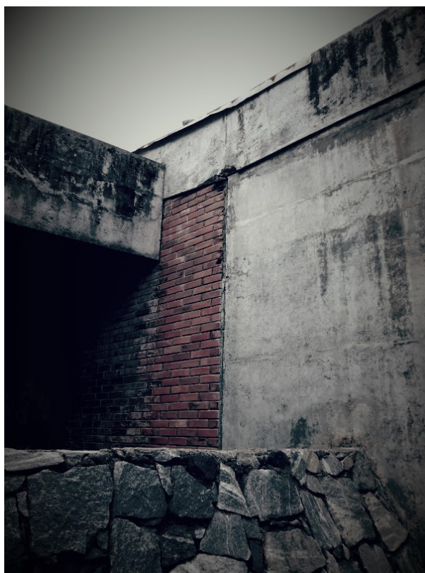
Figura 2 - Edifício da Secretaria de Cultura de Campina Grande
