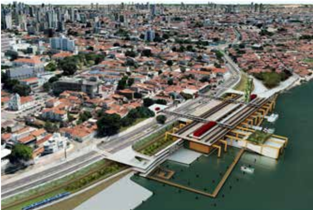
Figura 3 – Fachadas Nordeste e Noroeste entre a Pedra do Rosário, Centro Histórico e AEIS Passo da Pátria. Destaque para passarelas, escadaria, pier, torre e teto jardim mirante.
