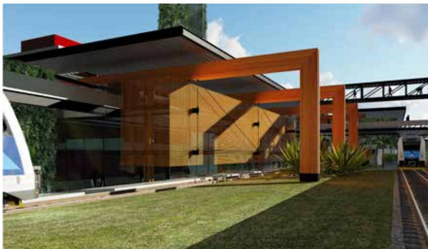
Figura 6 – Fachada Sudeste e Sudoeste com plataforma do VLT sob a linha férrea. Destaque para o sistema estrutural com cabos de aço aparente e atirantado ao pórtico de madeira
