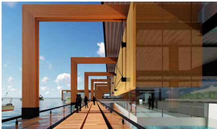
Figura 5 – Fachadas Noroeste e Sudoeste, vista do Pier sobre o rio Potengi. Destaque para o sistema estrutural com lajes sustentadas por cabos de aço aparente e atirantado ao pórtico de madeira
