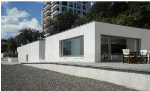
Figuras 30 e 31 - Contraste edifício e paisagem e textura das formas de concreto.
