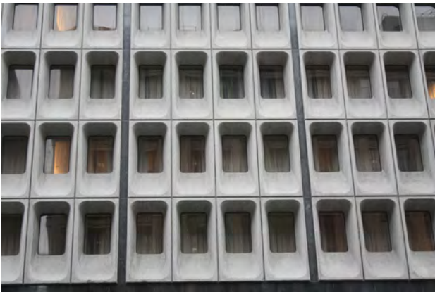
Figura 4: Detalhe dos painéis pré-fabricados na fachada frontal do edifício Cleveland Trust.
