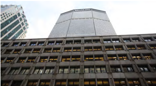
Figura 7: Vista da fachada norte do edifício Pan Am (MetLife) – embasamento + torre.
