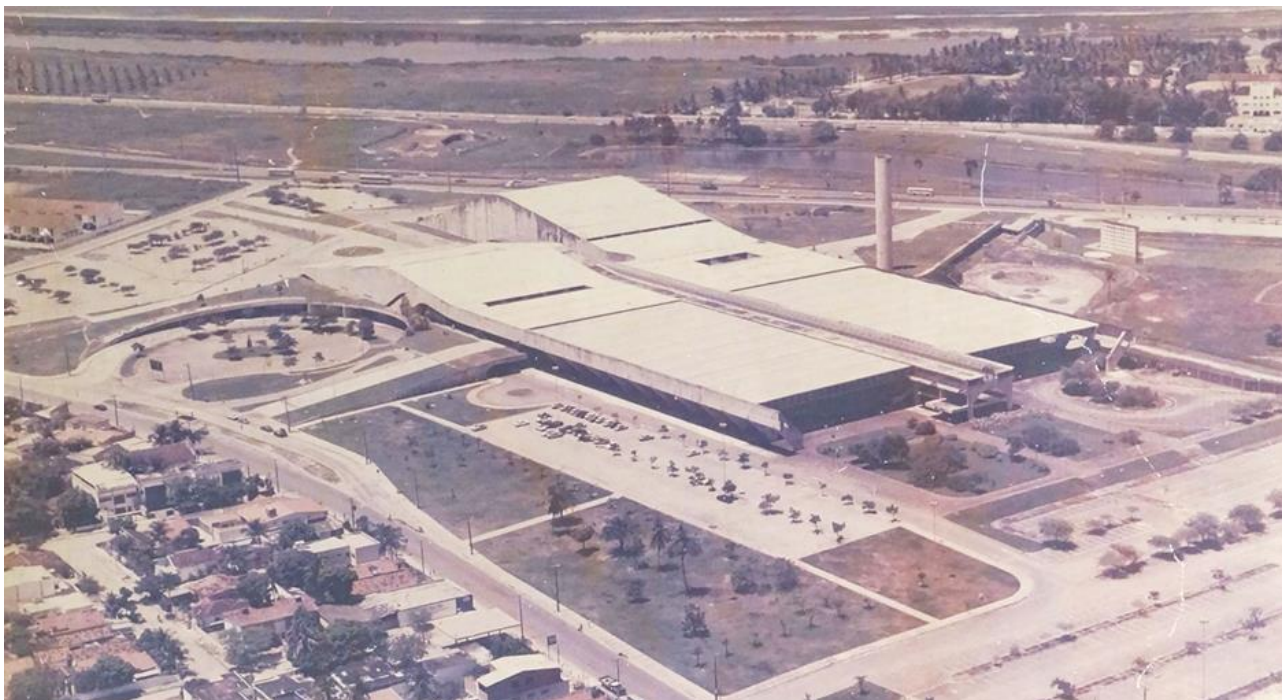
Figura 6: Os dois pavilhões do CeCon no Recife e a estrutura pré-moldada em espera no final.
