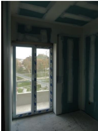
Figura 18: Novas esquadrias e adição de placas de gesso acartonado no dormitório
