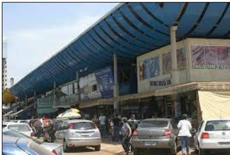
Figura 3: Área externa com Quiosques
